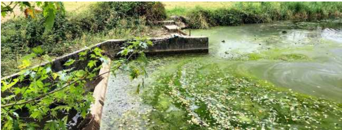
Figure 16 : état actuel, vanne de Curtafray et Reyssouze amont
