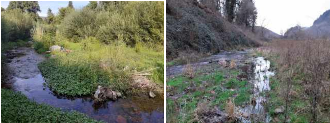
Figure 34 : recharges granulométriques colonisées par les hélrophytes
