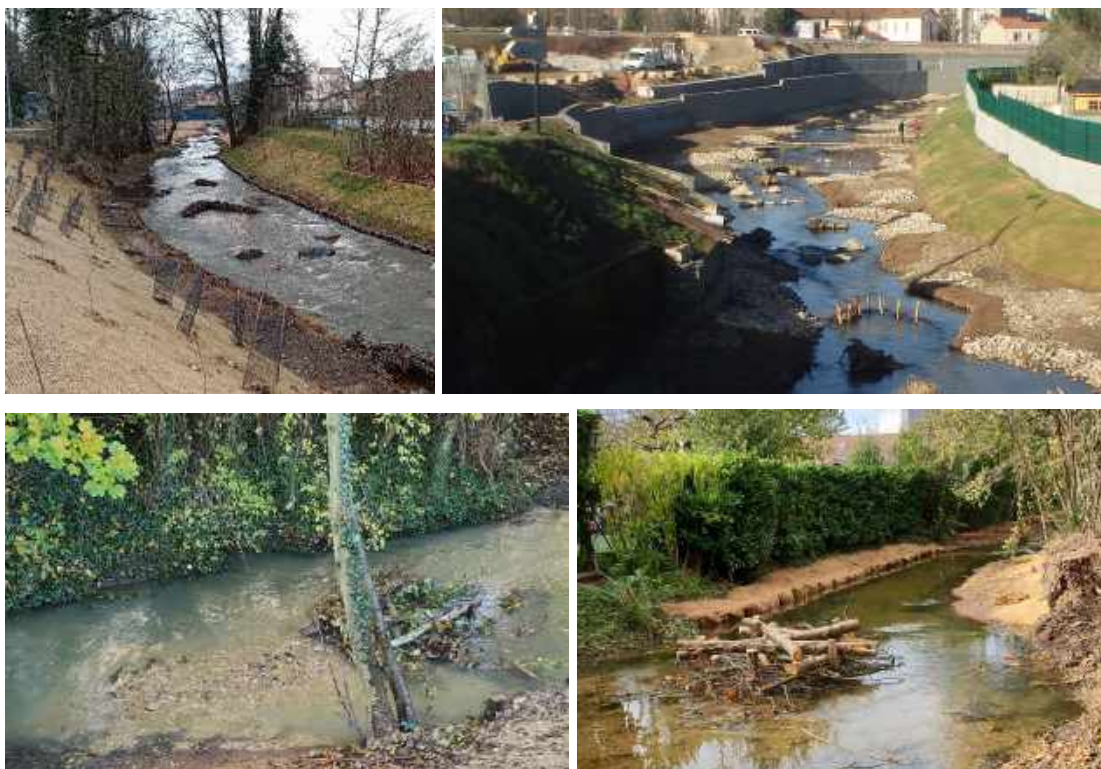
Figure 38 : épis centraux en fascines et peignes
