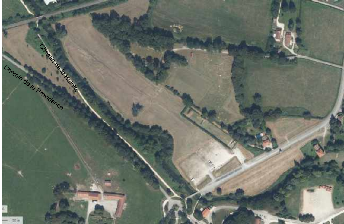
Figure 23 : Vue aérienne du TH3 en amont du pont SNCF
