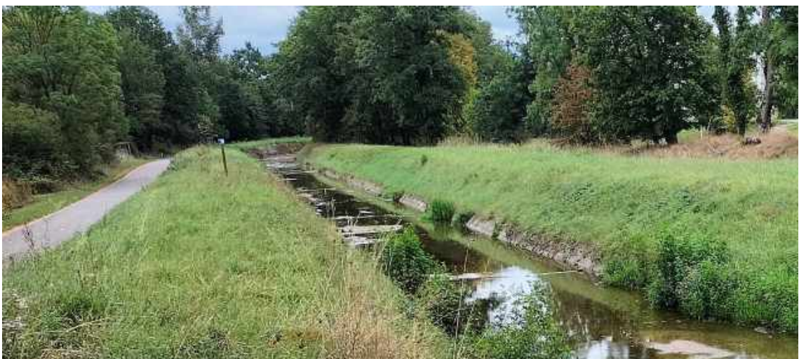
Figure 45 : merlons de rive droite et de rive gauche
