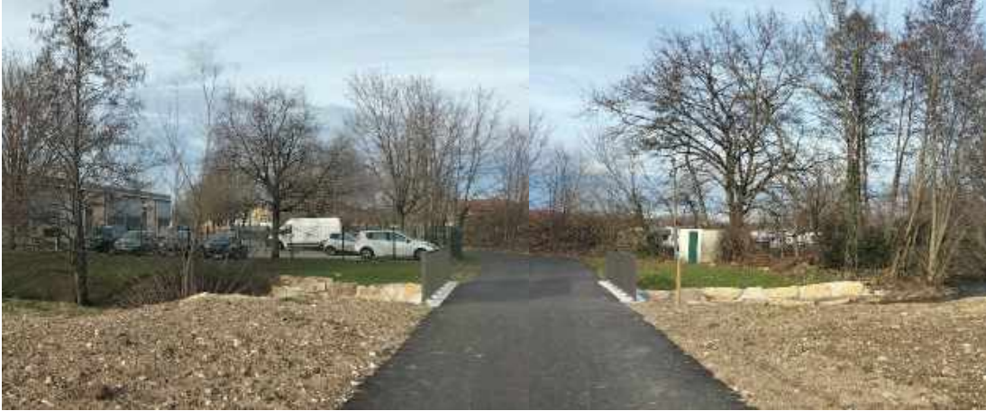
Figure 29 : nouvel ouvrage de franchissement du bras des moulins, octobre 2023
