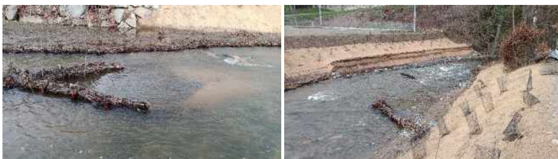
Figure 39 : effet d'une surverse pour une crue annuelle sur la création de mouilles et le tri granulométrique
