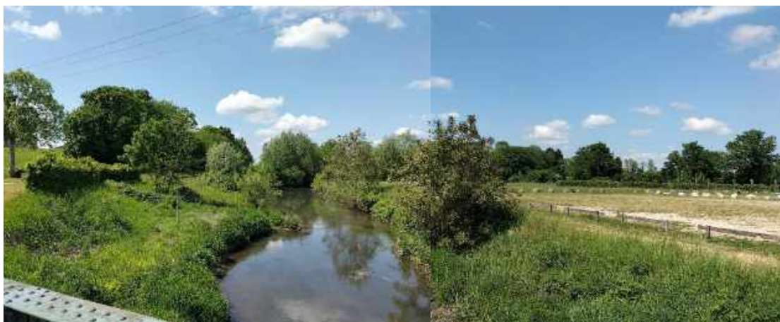
Figure 25 : TH3 amont influencé par l'ouvrage de Pennessuy
