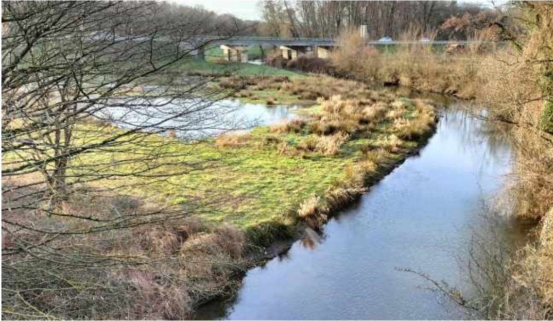
Figure 14 : dénoisement actuel de la rive droite au droit de l'aménagement de la Garde (-30 cm environ) suite à l'abaissement de la vanne de Curtafray
