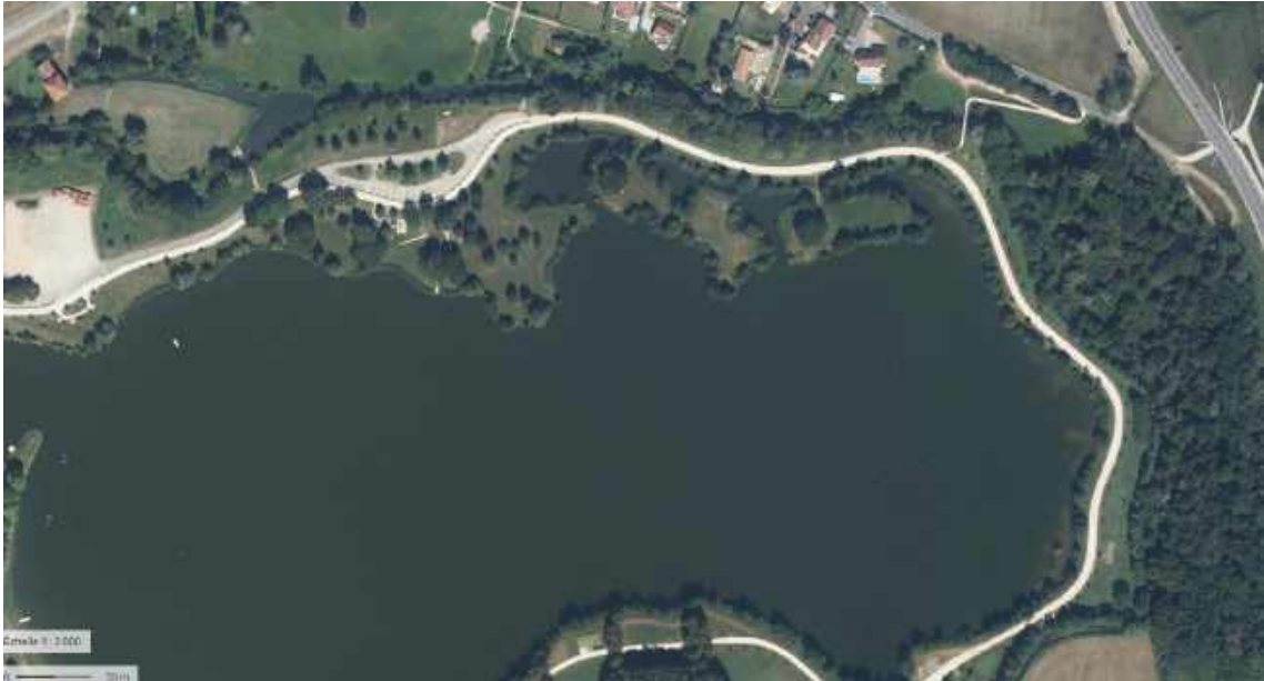
Figure 15 : Vue aérienne du TH2 en amont du moulin
