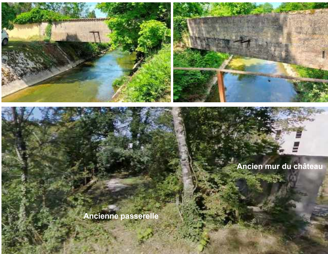
Figure 53 : franchissements sur le canal au droit des enceintes du château
