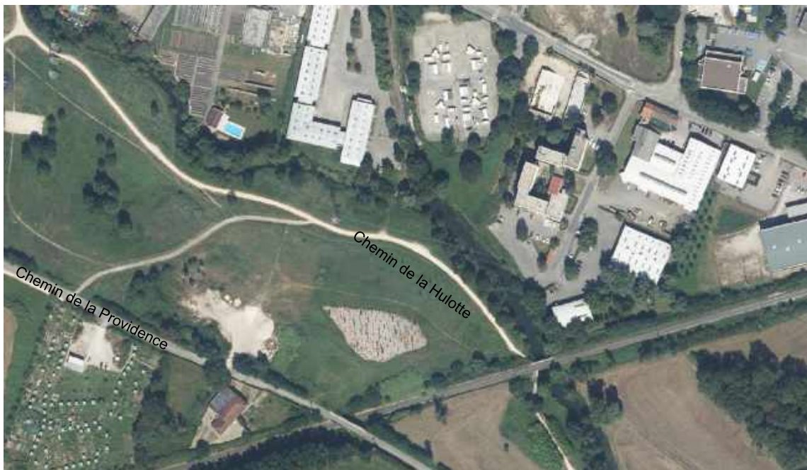
Figure 24 : Vue aérienne du TH3 en aval du Pont SNCF
