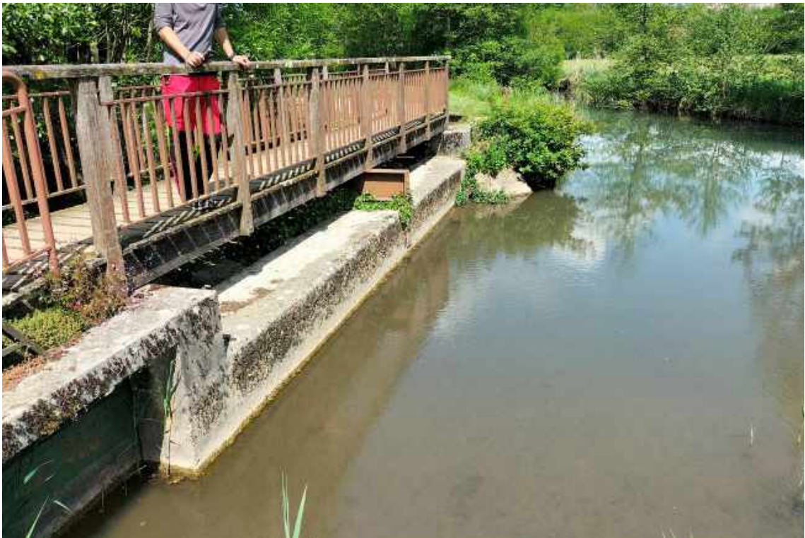
Figure 9 : ouvrage de connexion entre la Reyssouze et le Lac de Bouvent
