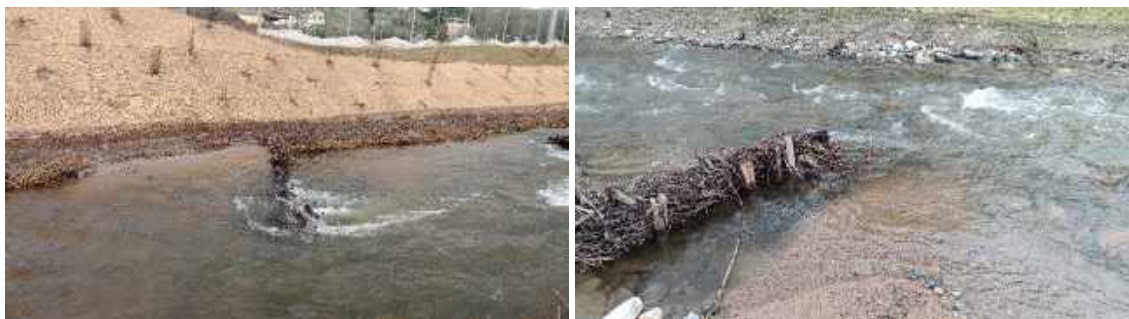
Figure 37 : exemple d'épis latéraux - impacts sur la granulométrie du substrat et la formation de mouilles
