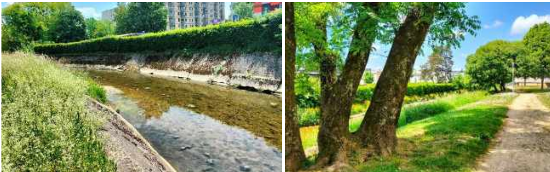
Figure 55 : état actuel TH7, berges bétonnées sur le linéaire amont VS berges naturelles et arbres à conserver en rive droite
